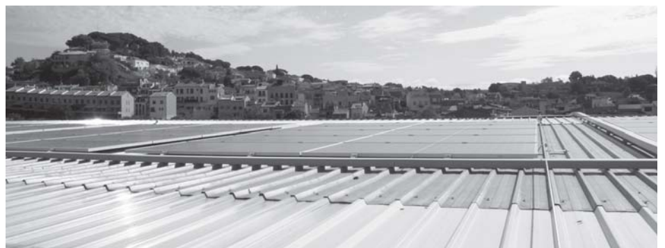
Noves plaques solars damunt la coberta del pavelló.
